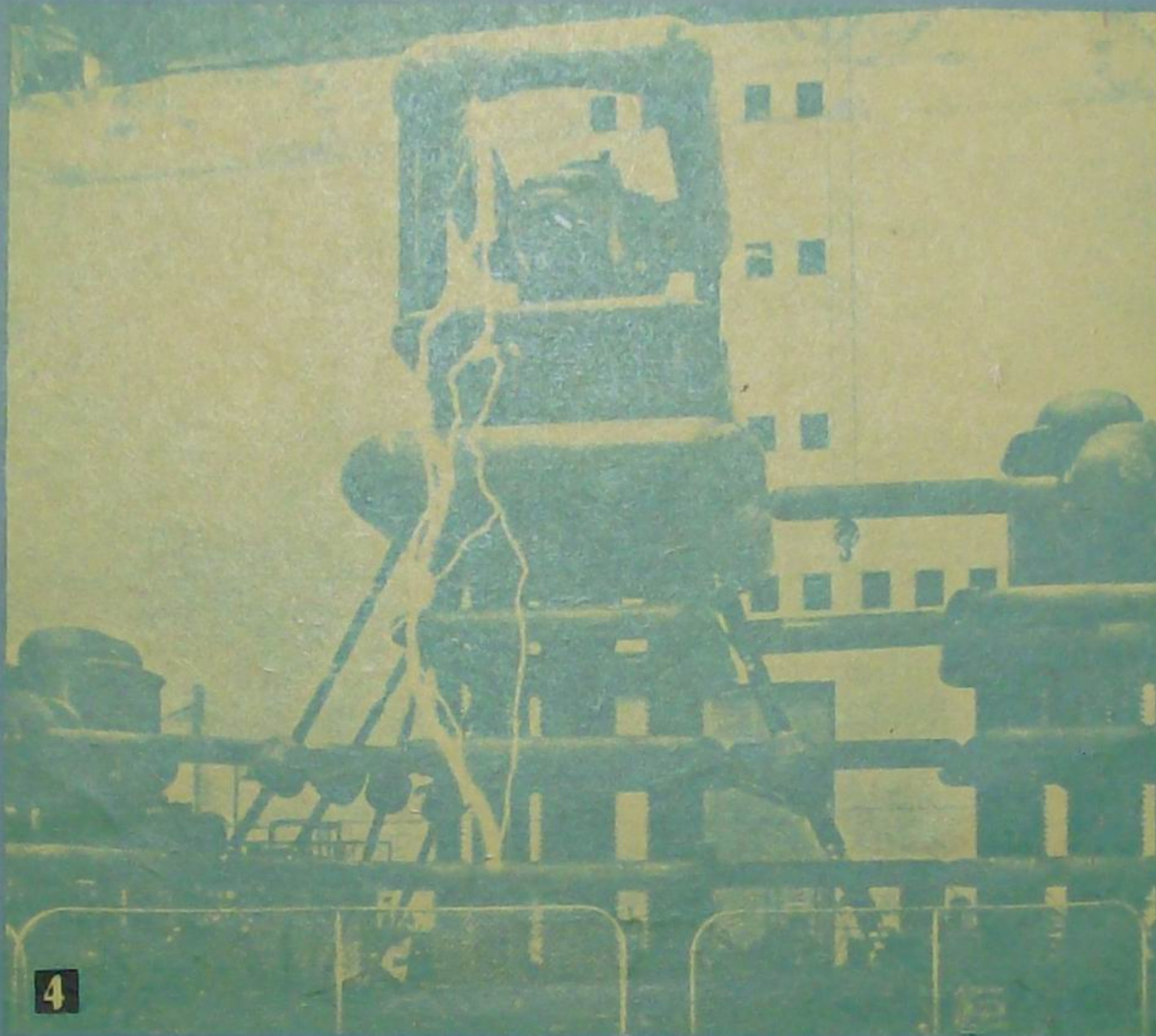
patru transformatoare de 750 kV (2 A), prin care se realizează o însumare a tensiunii acestora.
